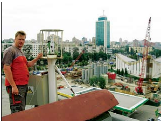
Автоматизированная геодезическая система для наблюдений объекта строительства
